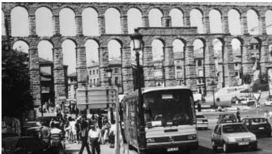
Aquädukt von Segovia. Seit über 2000 Jahren Brücke zwischen Kulturen und schon mehrfach Reiseziel der AGIJ.
