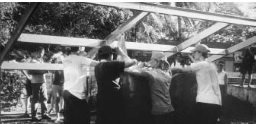
Projektteilnehmer beim Aufbau der Solaranlage in Nicaragua.
